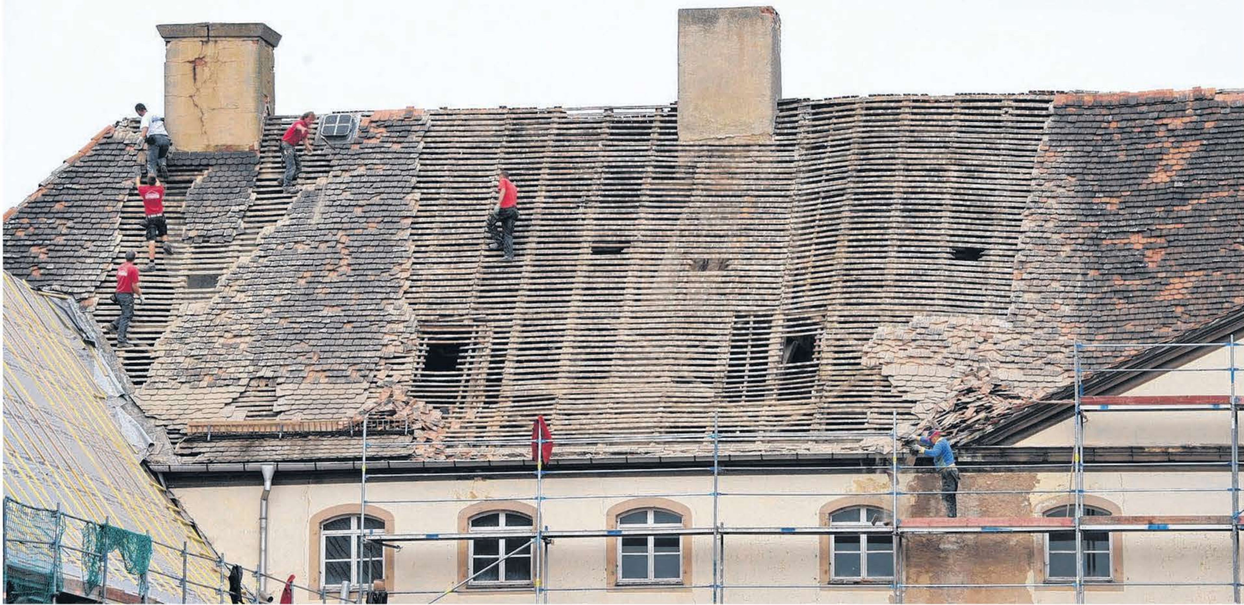
Das Hauptgebäude des Walbecker Schlosses erhält jetzt ein neues Dach.
